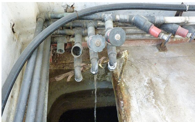
Adăugarea soluției de sulfat de aluminiu în apa brută din Dunăre
